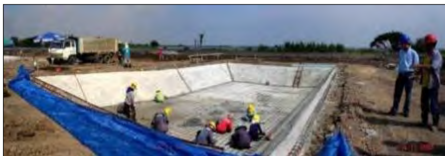
ขั้นตอนการผูกเหล็กและเตรียมเทคอนกรีตขั้นสุดท้าย
