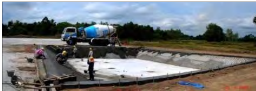
การเทคอนกรีตพื้น และผนังบ่อ
